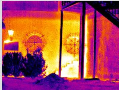
*Wärmeverluste durch Heizkörper
