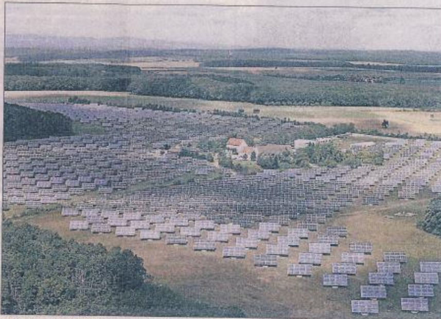
Solar satt mit Zukunftsperspektive: Der Solarpark Gut Erlasee bei Arnstein hat eine Gesamtleistung von zwölf Megawatt und eine Produktion von 14 000 Megawattstunden pro Jahr. Fotos: dpa, Breuer
